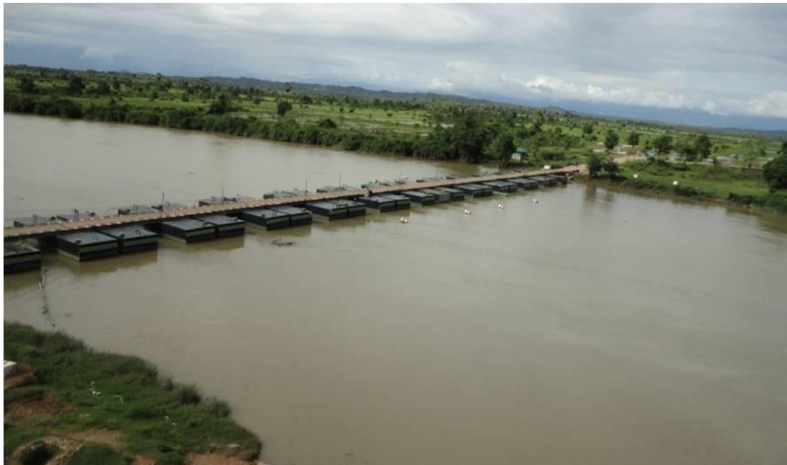
Temporary Floating Pontoon Bridge (ယာယီရေပေါ်တံတားတည်ဆောက်ထားပုံ)
