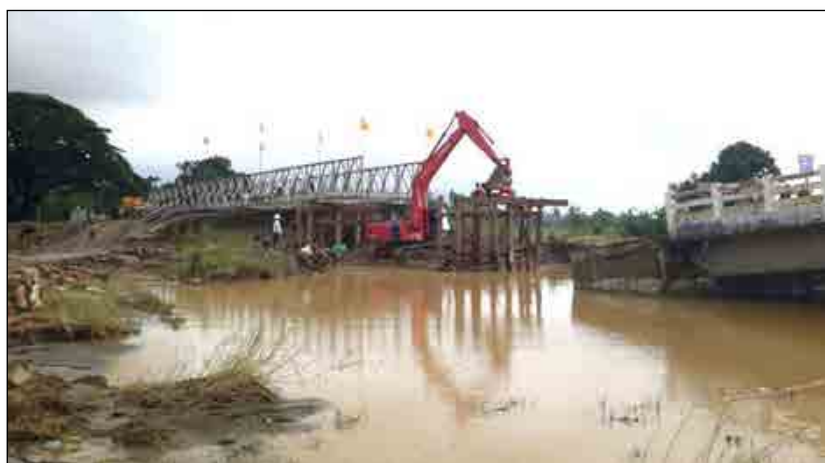
ဘေလီတံတားအစားထိုးတည်ဆောက်နေခြင်း
