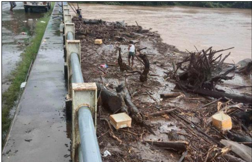
တံတား၏ Plate Girder များတွင် အမှိုက်နှင့်ဒိုက်များ ပိတ်ဆို့နေမှု အား ရှင်းလင်းခြင်းလုပ်ငန်းဆောင်ရွက်နေပုံ
