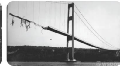
KATU Galloping Gertie: Looking b...
